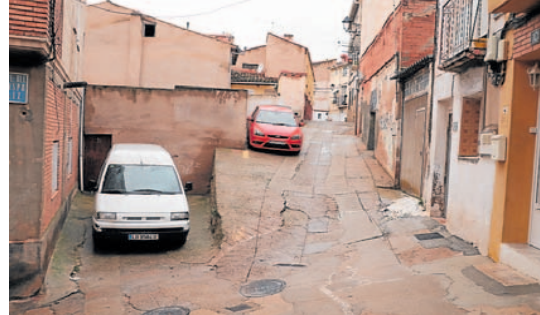
Fotografía tomada en la tarde del sábado, antes del hundimiento. E.R.
