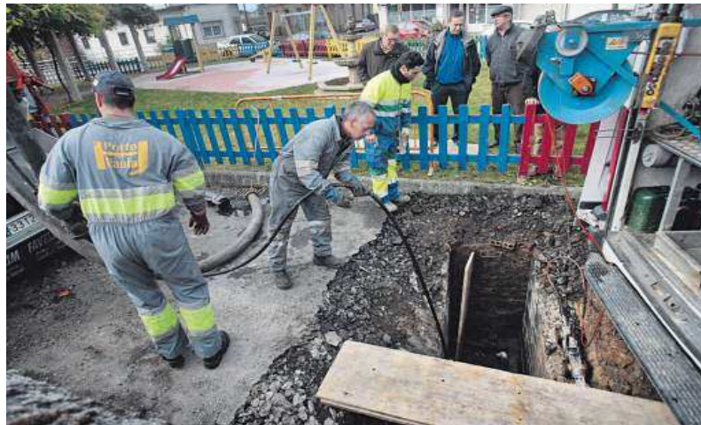
Personal de Aqualia repara la avería que dejó a todo Monforte sin agua en el 2017. CARLOS CORTÉS
